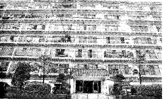
配管延命と水の活水化を目的に「パイプテクター」を設置した東京・北区の「秀和東十条レジデンス」
