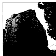
メトロエステート西薬橋
