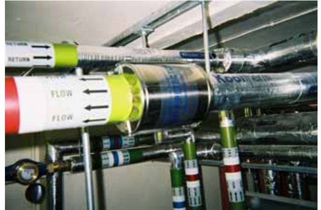
NMR パイプテクター設置箇所
