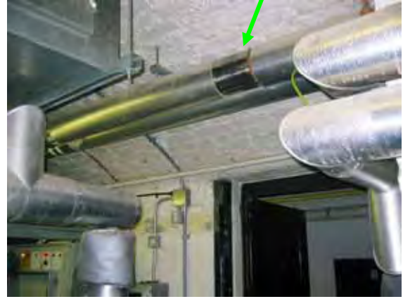
NMRパイプテクター設置箇所
