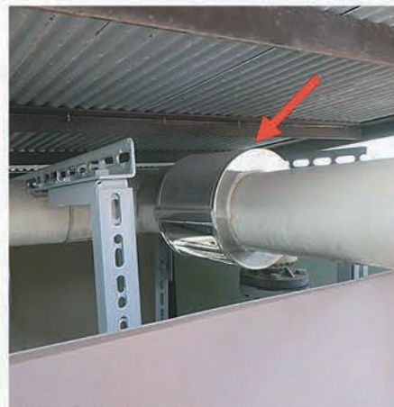
パイプテクターを高架水槽2次側配管(左)と揚水ポンプの2次側配管(右)に設置
