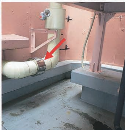
パイプテクターを高架水槽2次側配管(左)と揚水ポンプの2次側配管(右)に設置
