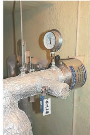
圧力タンクの2次側給水配管にパイプテクターを設置
